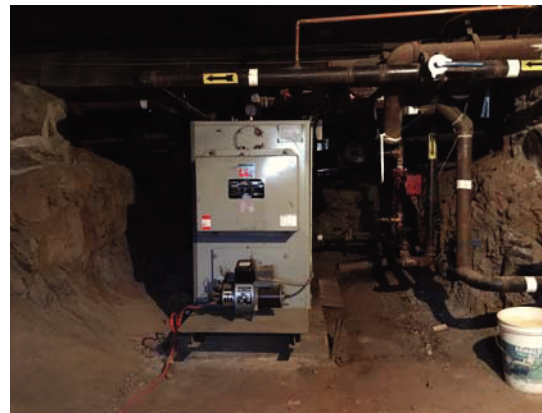
Chaudière au mazout
