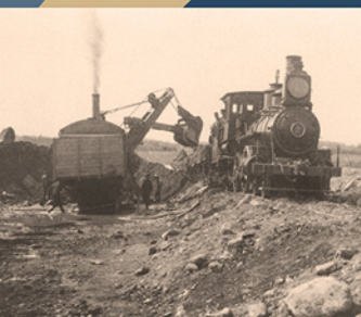
Construction du tronçon Monk... la locomotive suit les travaux Collection Jacques Saint-Pierre
