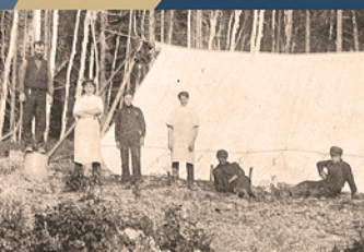
Le défrichement et la construction se font loin des habitations. Collection Mariette-Saint-Pierre
